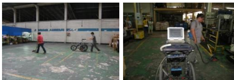
รูปที่ 7 ภาพการทดสอบพื้นอาคารในนิคมบางปูจังหวัดสมุทรปราการด้วย (GPR)
